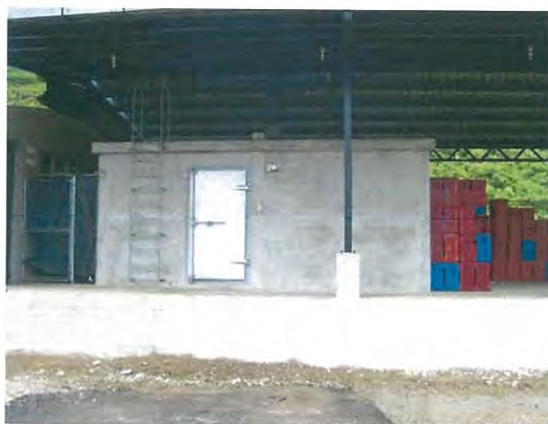
Figura 10. Cámara de fumigación de concreto.
