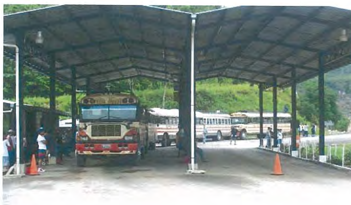
Figura 4. Inspección de buses.
