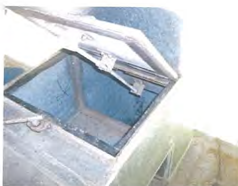
Figura 11. Válvula de escape de la chimenea.
